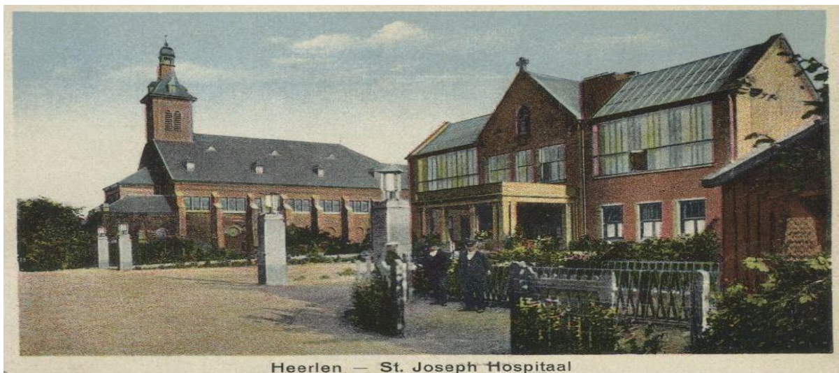
Heerlen — St. Joseph Hospitaal
