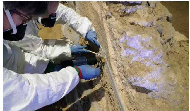
Afb. 3: Het herstel van het stucwerk (foto: Restaura).
