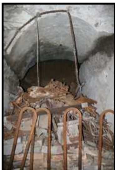
Bewapende betonconstructie Fort Loncin
